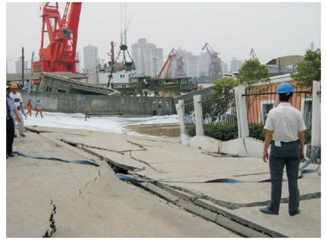
图 2 路面裂缝、塌陷
