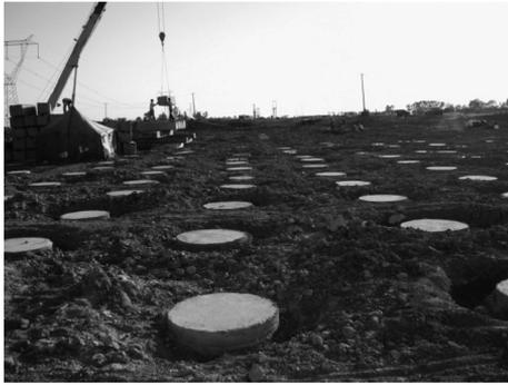
图5 PCC 桩成桩示意图
