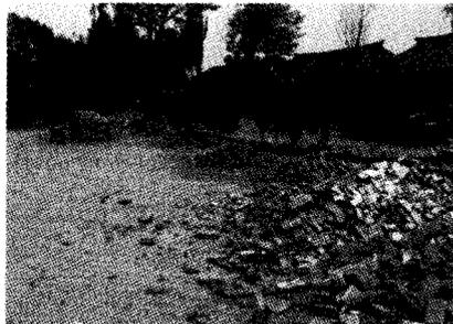
图 6 东西向长围墙倒塌与土坯墙完好并存
